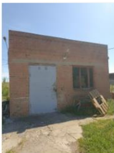
6. Литер Щ Здание Насосной
