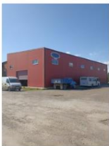
Лит. Б Здание склада
