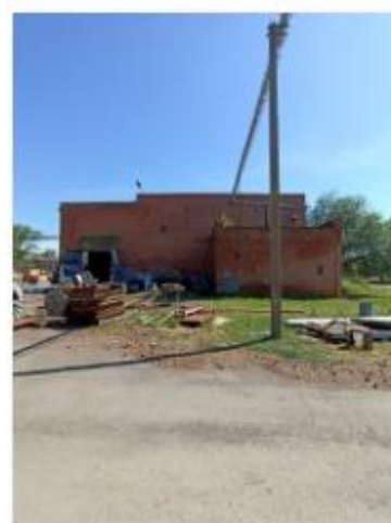
Лит. Д,нД,д Здание производственного склада
