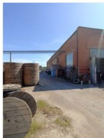
Лит. Д,нД,д Здание производственного склада
